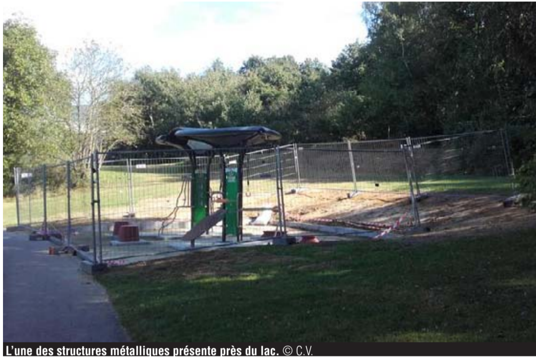
L'une des structures métalliques présente près du lac. © C.V.
